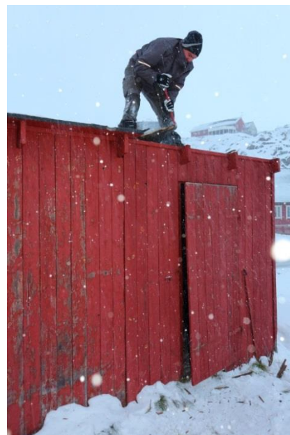
Skuret under nedrivning. Døren blev bevaret og indsat i det nye skur.
